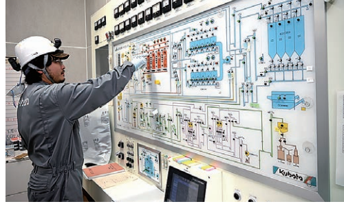
試運転するオペレーター
